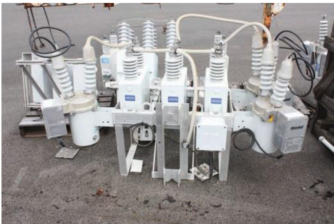
600 kvar Capacitor Bank
