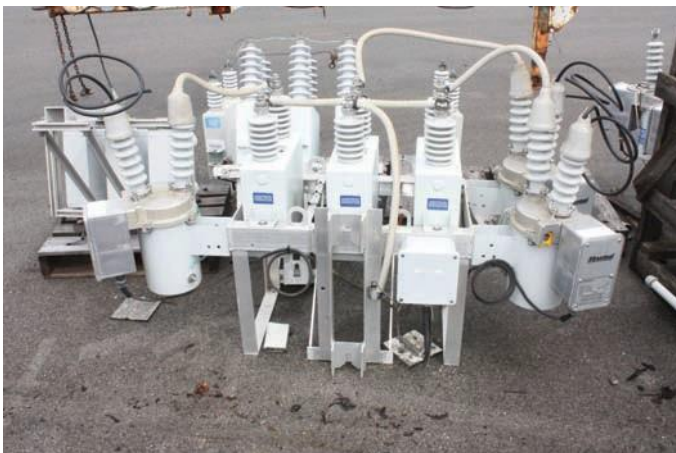
600 kVAr Capacitor Bank
